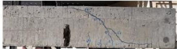
b) Viga con agregado reciclado sin estribos
