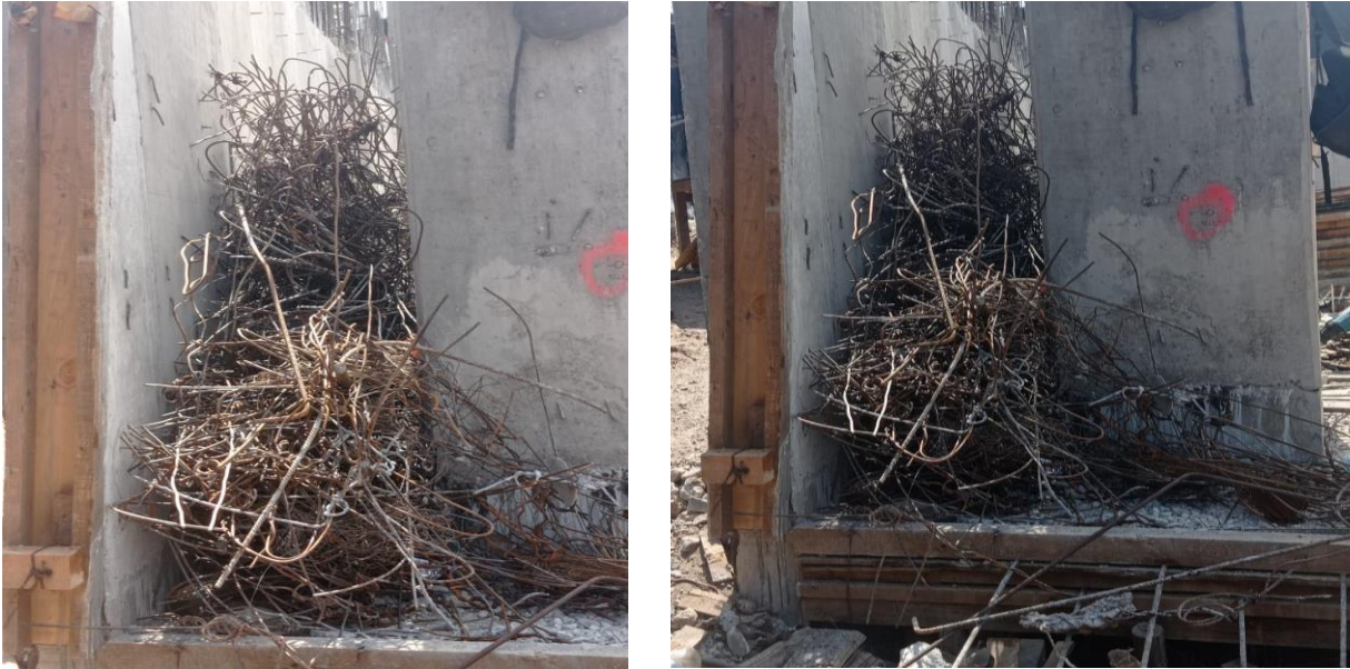
Imagen 6 Demostración de residuos de acero en obra.
