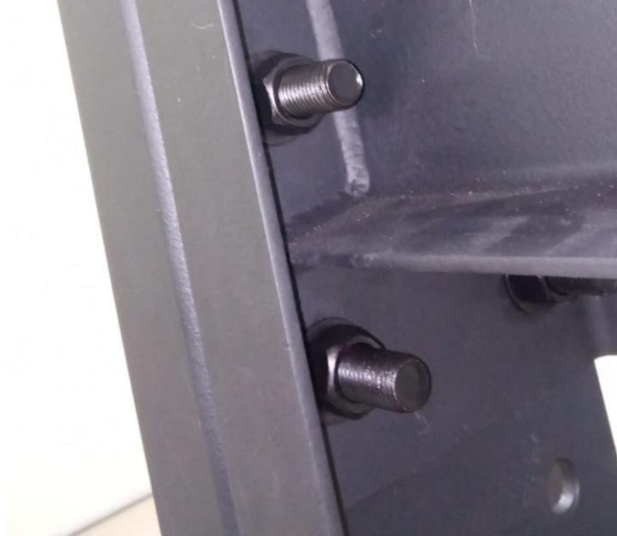
Ilustración 17. Vista interior de la unión entre viga y columna.
