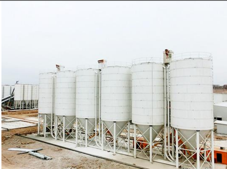
ILUSTRACIÓN 9. SILOS PARA ALMACENAR CEMENTO.
