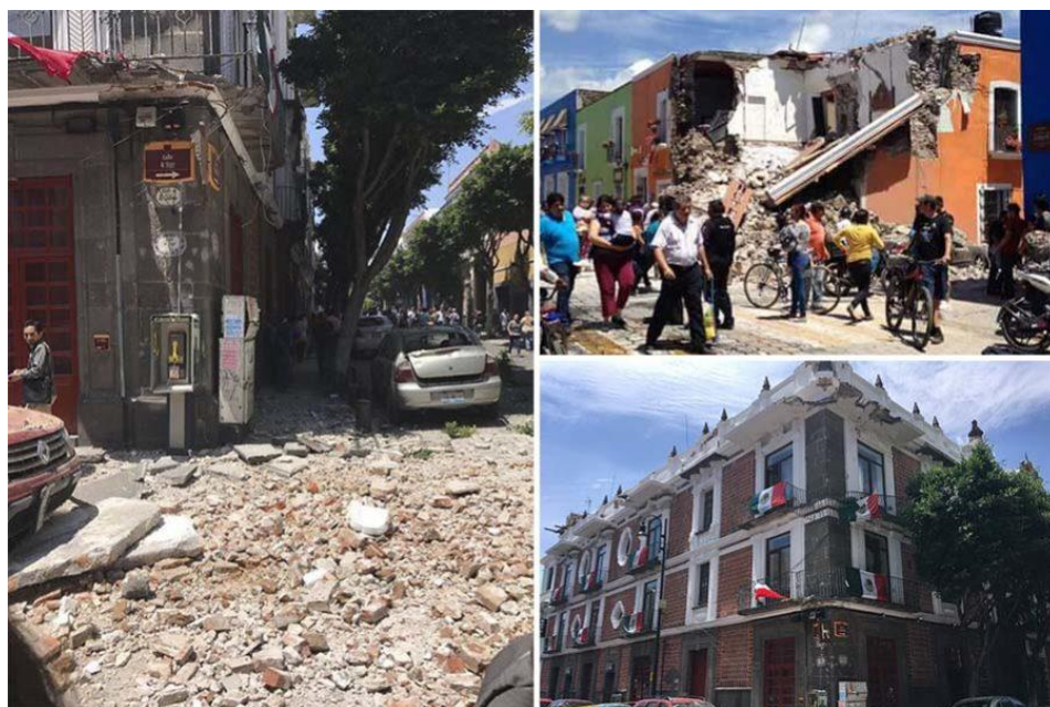
Figura 1.13 Primeras imágenes de los estragos del sismo en Puebla. Diario Tiempo México (2017) 16
