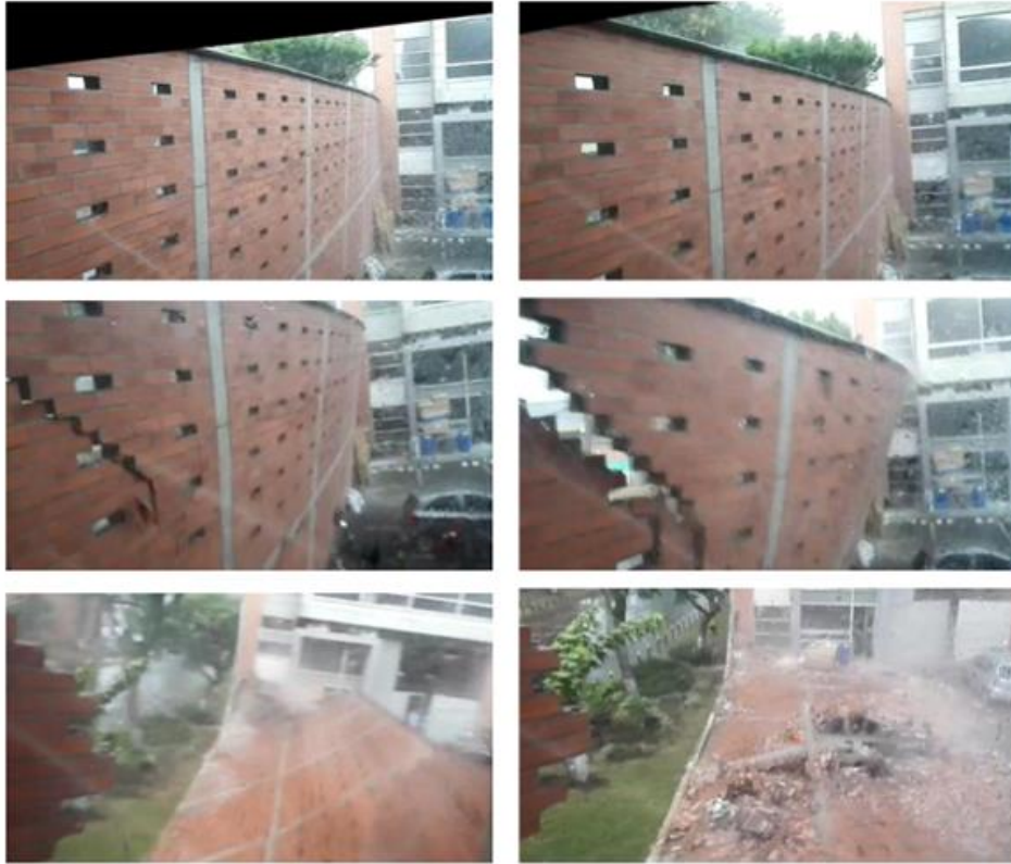
Figura 1.24 Secuencia del colapso. Aviram, A., Badillo, J., Prieto, J. L., & Jaramillo, J. (2019). 25
