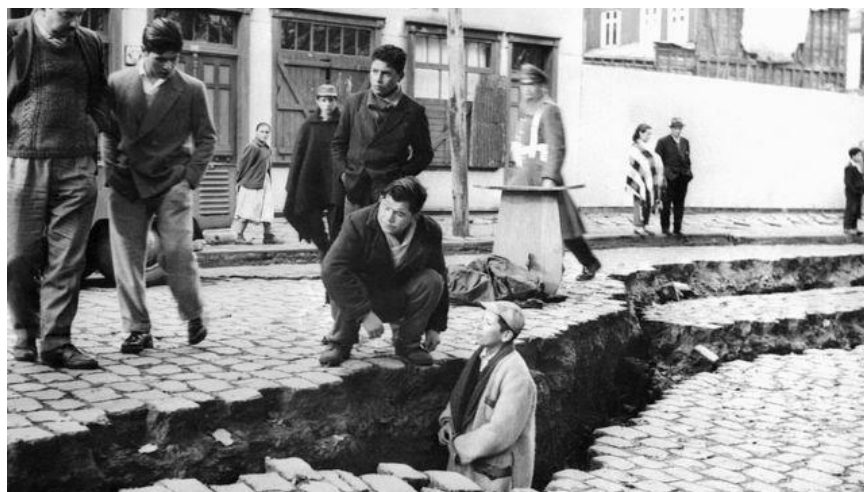
Figura 1.20 Grietas provocadas por el temblor de 1960. BBC News Mundo. (2020). BBC News Mundo. (2020b) 21
