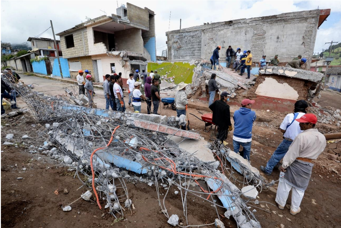
Figura 1.2 Colapso de viviendas. Uribe, A. (2017). 4
