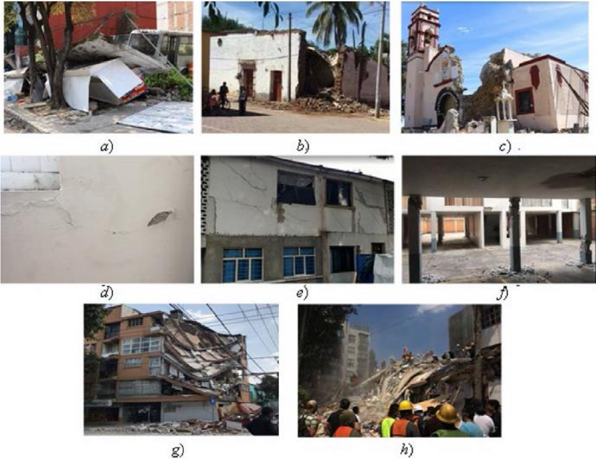
Figura 1.8 Algunos ejemplos de estructuras dañadas en el sismo de septiembre de 2017. Buendía y Reynoso (2019) 10
