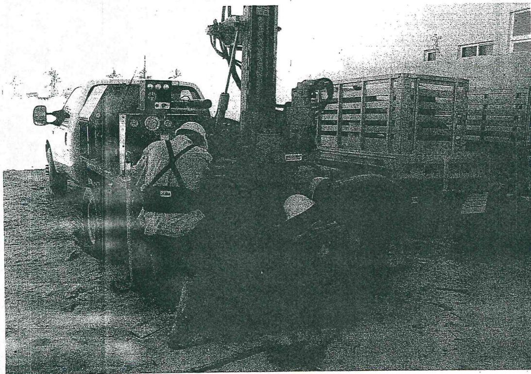
Obteniendo muestras de un suelo, con el equipo de penetración estándar.
