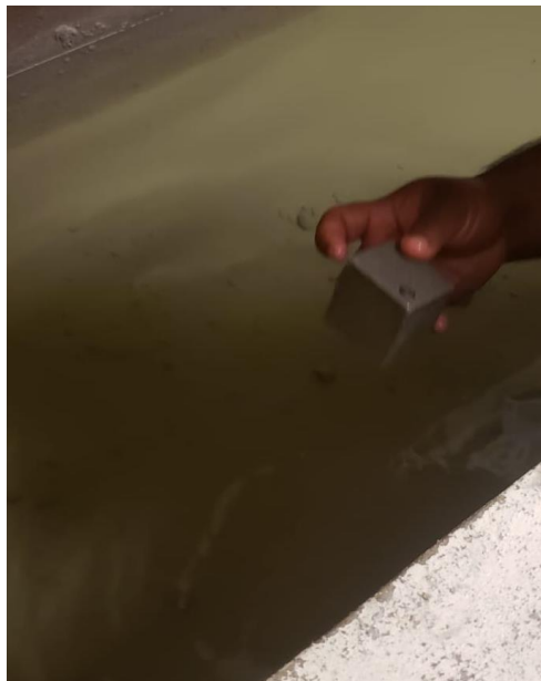
Ilustración 27. Preparación de cubo de ensayo de mortero para unión para formación de pilas.
