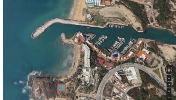
Figura 3. Entrada a Marina Mazatlán, Sin.
