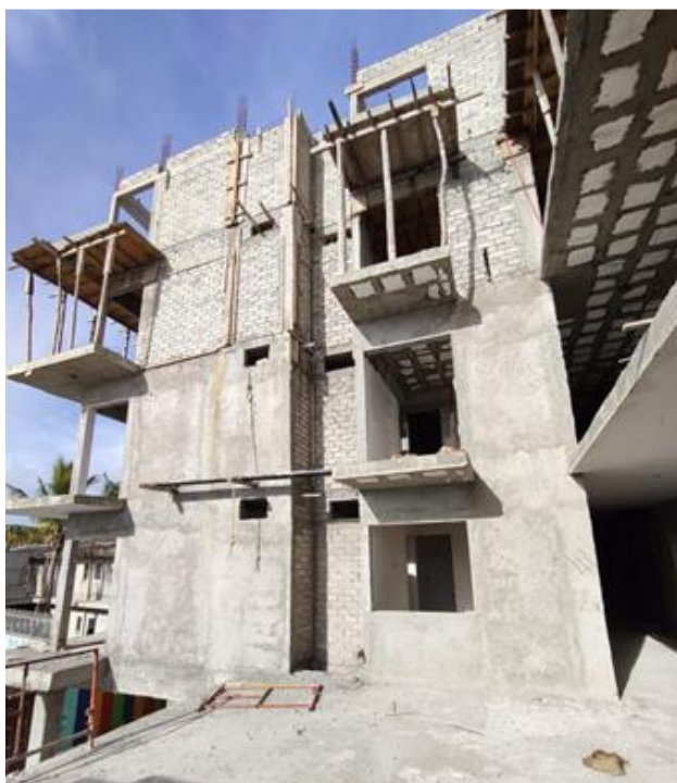
Ilustración 2. Construcción de viviendas multifamiliares de cinco niveles con muros de jalcreto.
