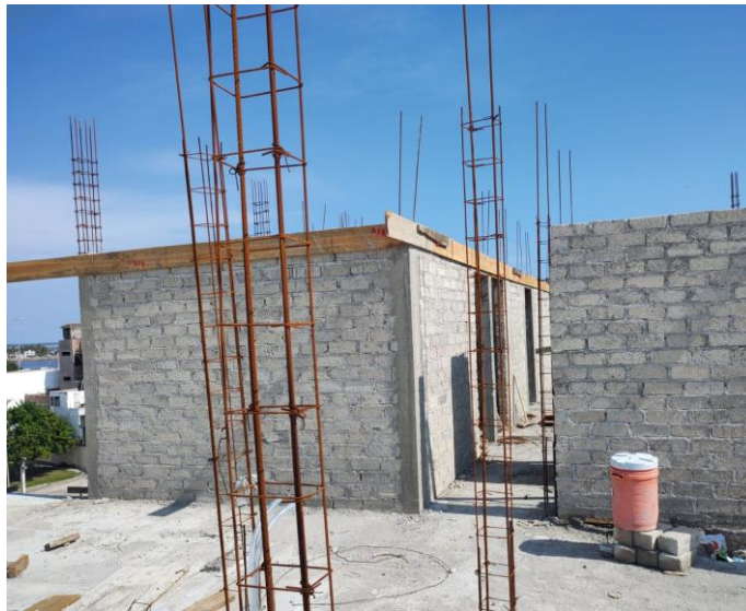
Ilustración 14. Utilización de tabique de jalcreto en muros.
