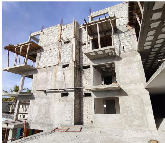
Ilustración 15. Empleo de tabique de jalcreto en edificación de 3 niveles.
