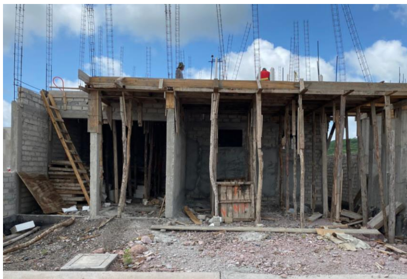
Ilustración 1. Vivienda unifamiliar construida con tabiques de jalcreto.
