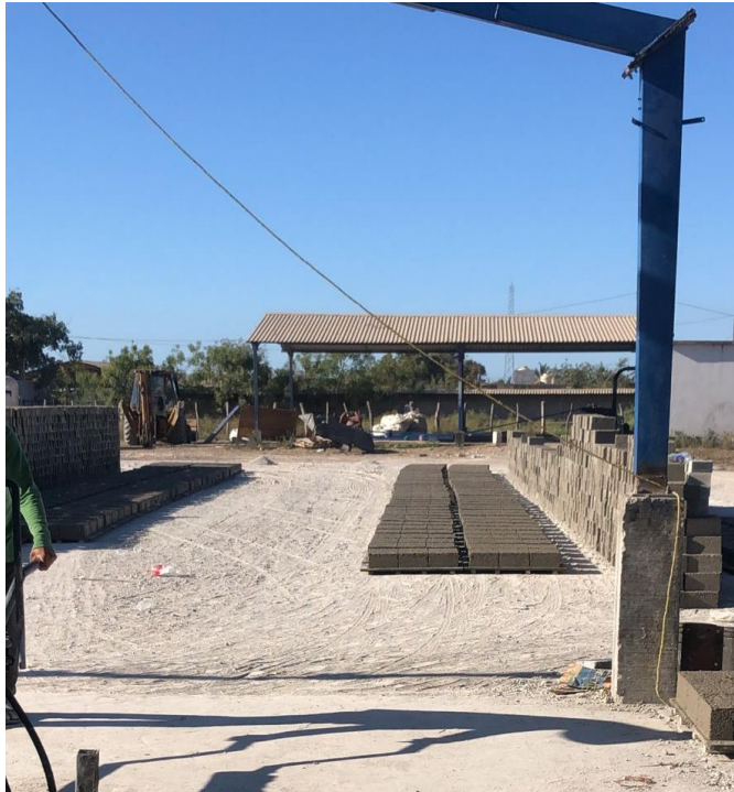
Ilustración 18. Proceso de almacenaje y fraguado de los tabiques de jalcreto.
