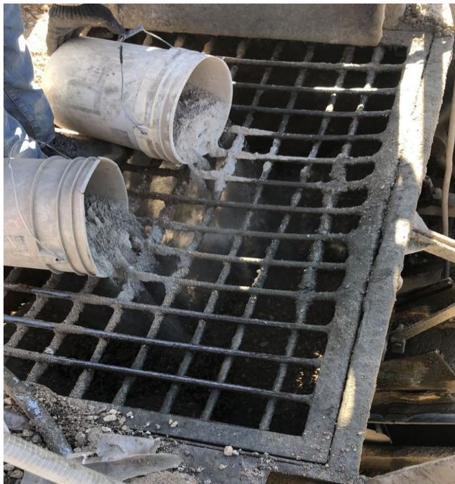
Ilustración 16. Mezcla de material seco (cemento y jal).
