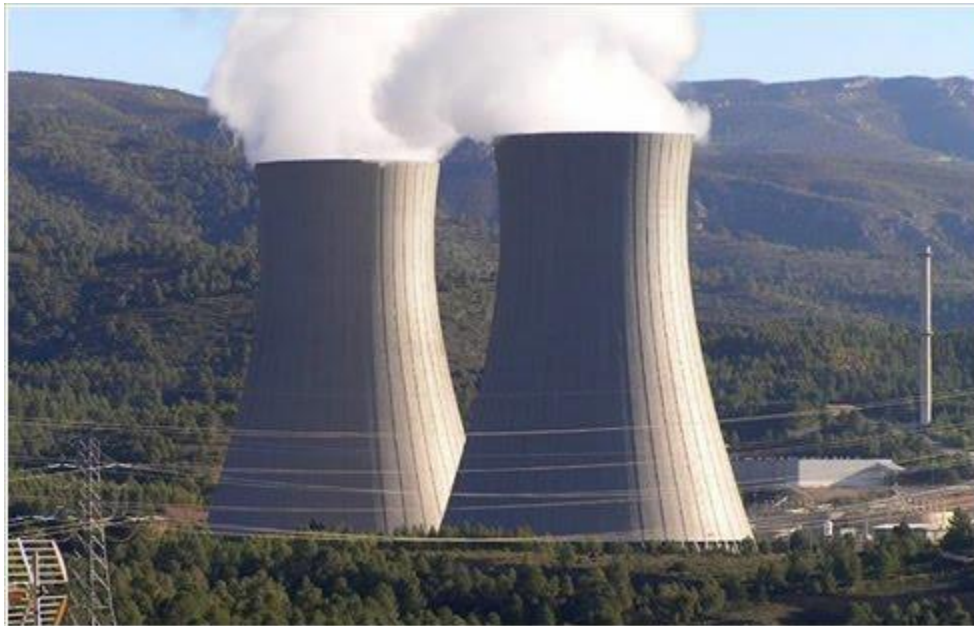
Figura 20. Aplicación del concreto de alta densidad como blindaje de radiación en una planta nuclear. Fuente: CivilGeeks (Julio Montenegro Gambini), disponible en: https://civilgeeks.com/2011/09/25/el-concreto-pesado-y-sus-aplicaciones-reactor-del-centro-nuclear-de-huarangal-peru/
