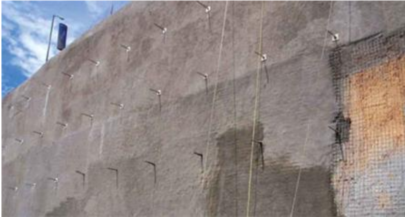
Figura 10. Ejemplo de obra donde se empleó el concreto lanzado. Fuente: IMCYC (CGS), disponible en: https://www.imcyc.com/ct2009/jul09/mejor.htm
