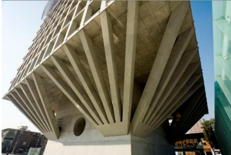
Figura 4. Ejemplo de una obra donde se utilizó el concreto autocompactante. Fuente: Arch Daily, disponible en: https://www.archdaily.cl/catalog/cl/products/1045/hormigon-autocompactante-cementos-bio-bio
