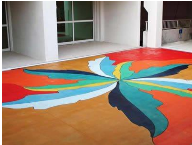
Figura 28. Aplicación del concreto coloreado para el diseño de un piso. Fuente: The Concrete Network (Anne Balogh), disponible en: https://www.concretenetwork.com/concreto-coloro/
