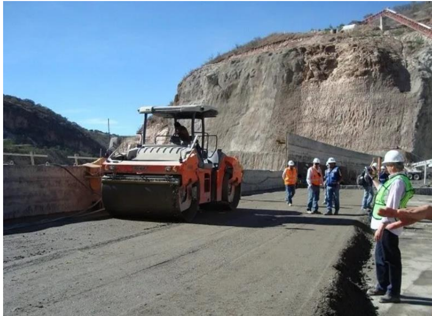
Figura 16. Aplicación de Concreto compactado con rodillo vibratorio. Fuente: 360 en Concreto (Elizabeth Londoño), disponible en: https://360enconcreto.com/blog/detalle/concreto-compactado-con-rodillo-1/
