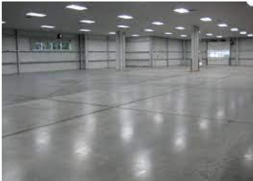
Figura 22. Aplicación del Concreto de Contracción Compensada en un piso industrial. Fuente: Revista CyT (Eduardo de J. Vidaud Quintana), disponible en: http://www.revistacyt.com.mx/index.php/10-posibilidades-del-concreto/255-breves-apuntes-acerca-de-la-construccion-de-pisos-industriales
