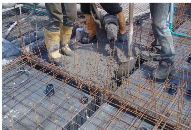
Figura 3. Colocación de concreto autocompactante. Fuente: Toxement disponible en: https://www.toxement.com.co/media/3373/concreto_autocompactante.pdf
