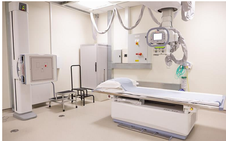
Figura 21. Aplicación del concreto pesado en una estructura hospitalaria expuesta a radiación. Fuente: Monkey Business Images , disponible en: https://www.mapadaobra.com.br/capacitacao/concreto-pesado-e-ideal-para-aplicacao-em-anteparos-radioativos/?doing_wp_cron=1672804369.1387948989868164062500
