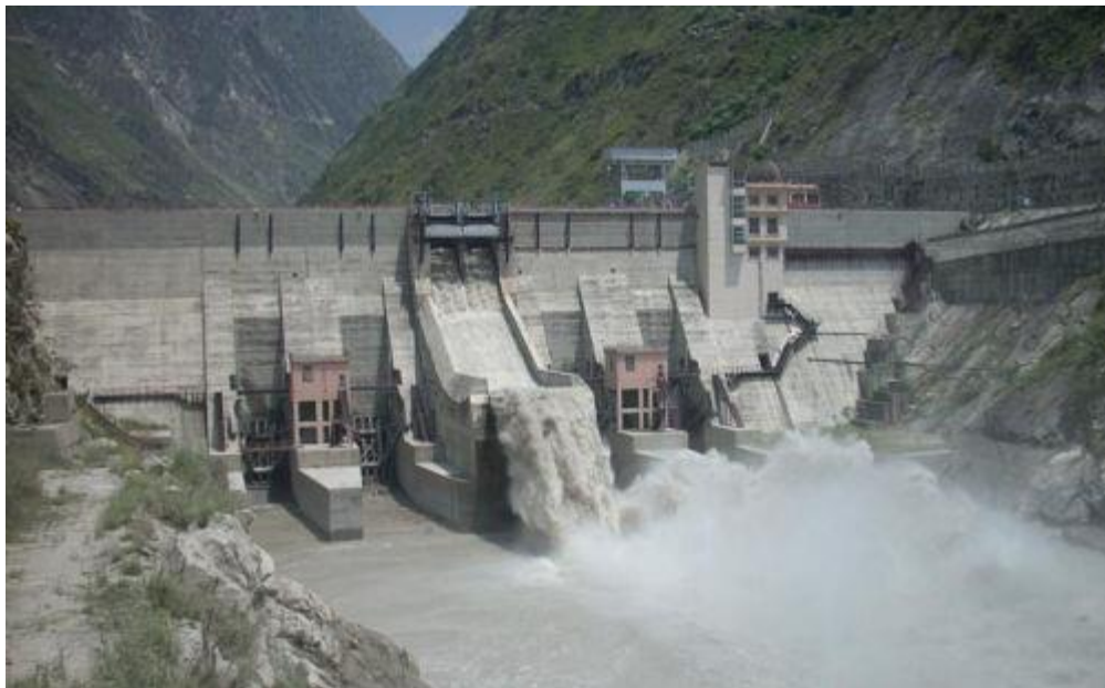
Figura 31. Proyecto hidroeléctrico Nathpa Jhakri. Fuente: The News Himachal , disponible en: https://thenewshimachal.com/2013/07/sjvn-registers-343-24-cr-profit-up-by-8-87-percent/
