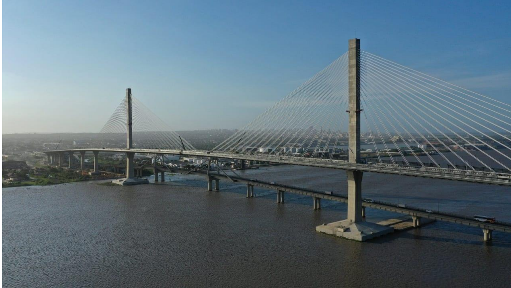
Figura 33. Puente Pumaréjo, Colombia. Con vista de los encepados hechos de concreto masivo. Fuente: Forbes, disponible en: https://forbes.co/2019/12/19/actualidad/los-problemas-que-empanan-la-apertura-del-nuevo-puente-pumarejo
