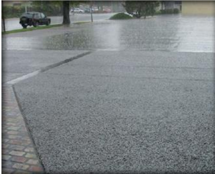
Figura 18. Aplicación del concreto permeable. Fuente: Revista CyT (Carlos Aire), disponible en: https://www.imcvc.com/revistacvt/jun11/arttecnologia.htm
