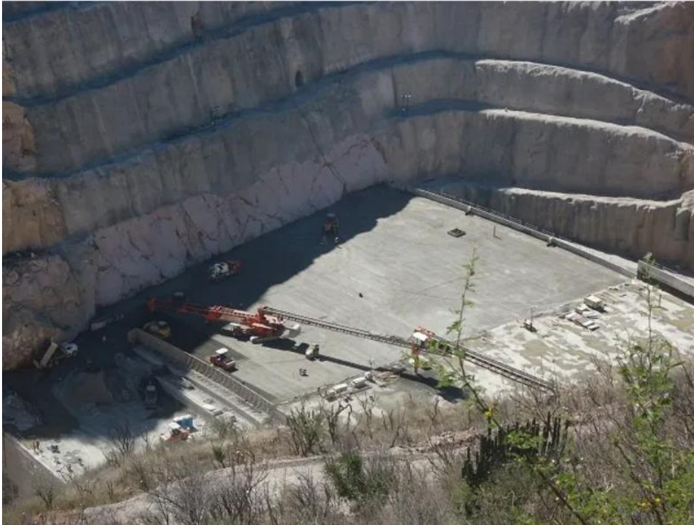
Figura 17. Aplicación del Concreto Compactado con Rodillo en la presa Zapotillo, en Jalisco, México. Fuente: 360 en Concreto (Elizabeth Londoño), disponible en: https://360enconcreto.com/blog/detalle/concreto-compactado-con-rodillo-1/
