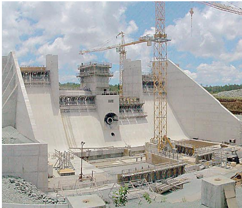
Figura 15. Ejemplo de concreto masivo utilizado en una obra. Fuente: (Loor Torres, 2015)
