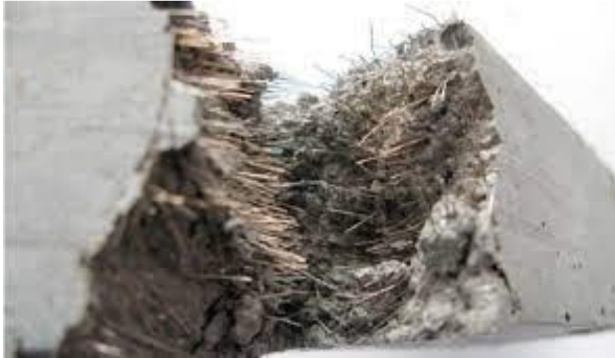
Figura 13. Vista de un concreto reforzado con fibras en estado endurecido. Fuente: Más que Ingeniería, Disponible en: https://masqueingenieria.com/blog/hormigones-especiales-hormigon-reforzado-con-fibras/
