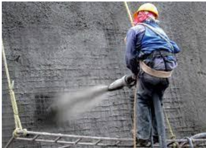
Figura 9. Aplicación del concreto lanzado. Fuente: Revista CyT, disponible en: http://www.revistacyt.com.mx/index.php/23-especial/134-concreto-lanzado-para-tuneles-y-taludes
